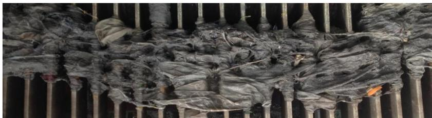
1. Toallitas desechables que se acumulan en el equipo de filtración en la planta de tratamiento de aguas residuales en FM 830
